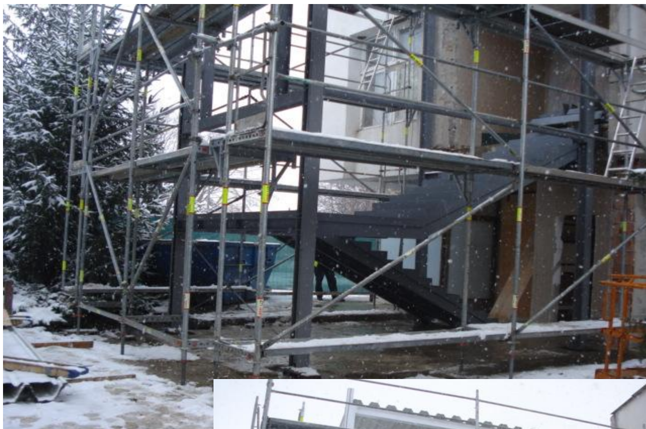
§ priebeh rekonštrukcie - schodisko
