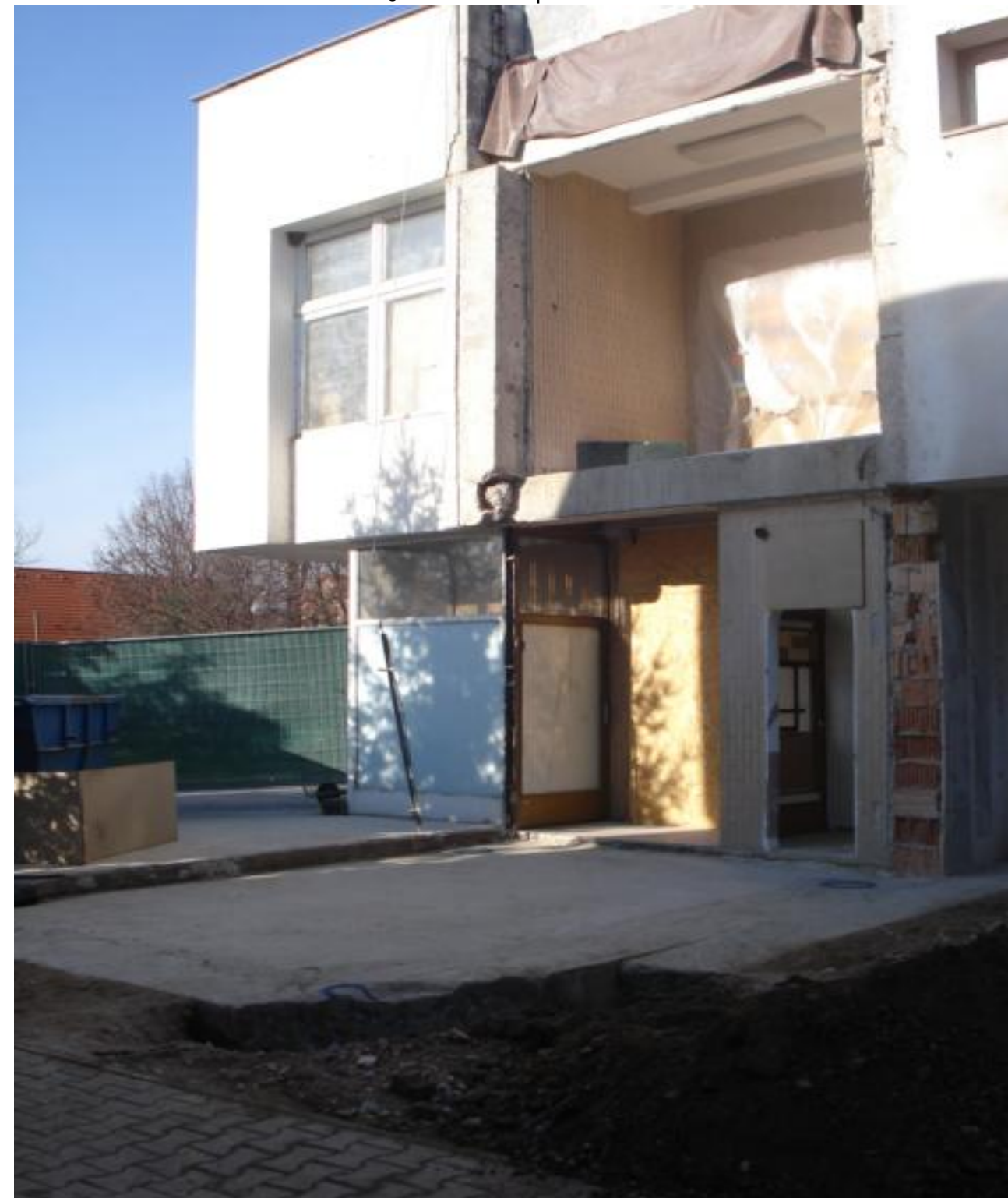
§ büracie práce - schodisko
