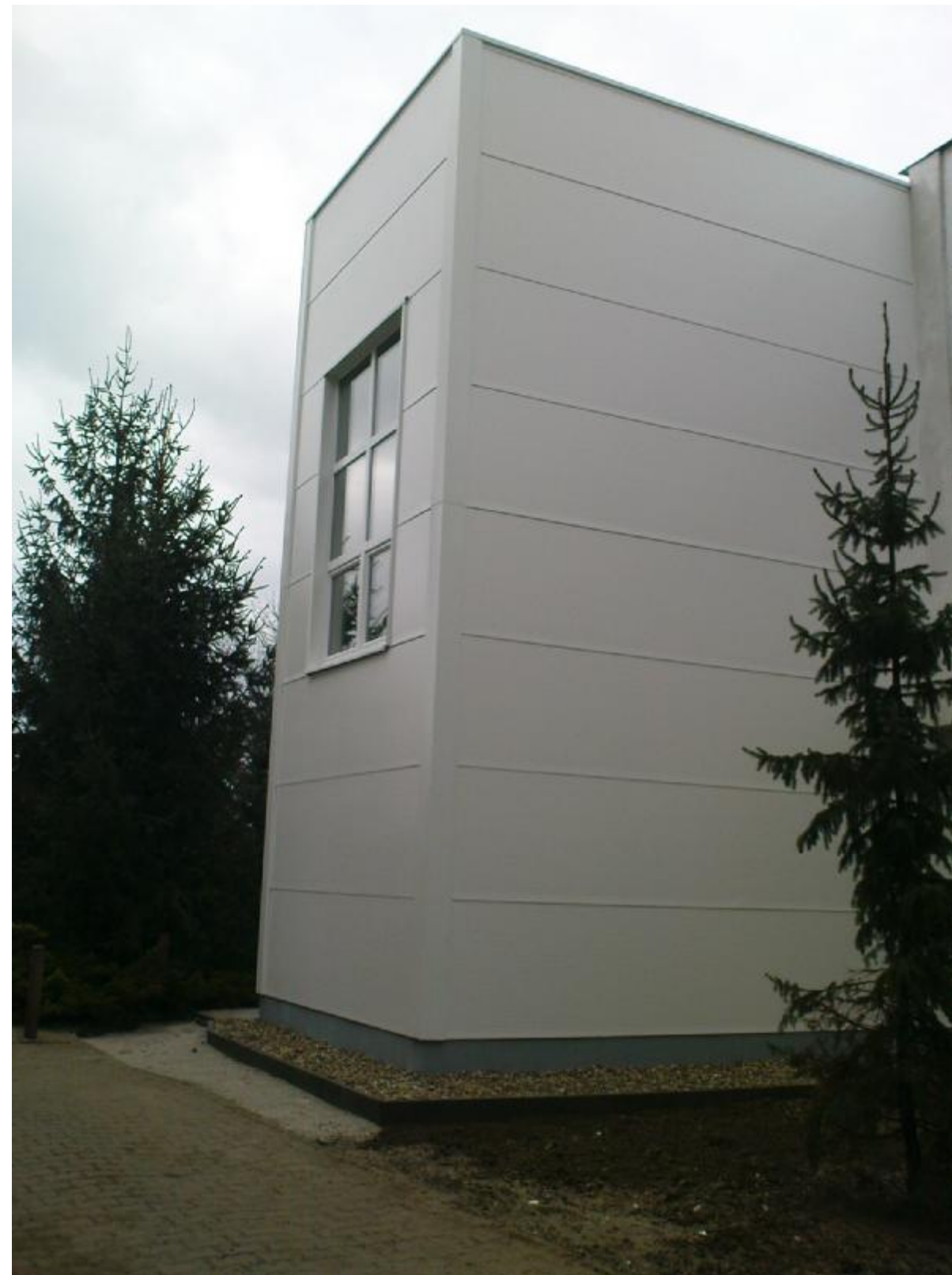
§ po rekonštrukcii - schodisko
